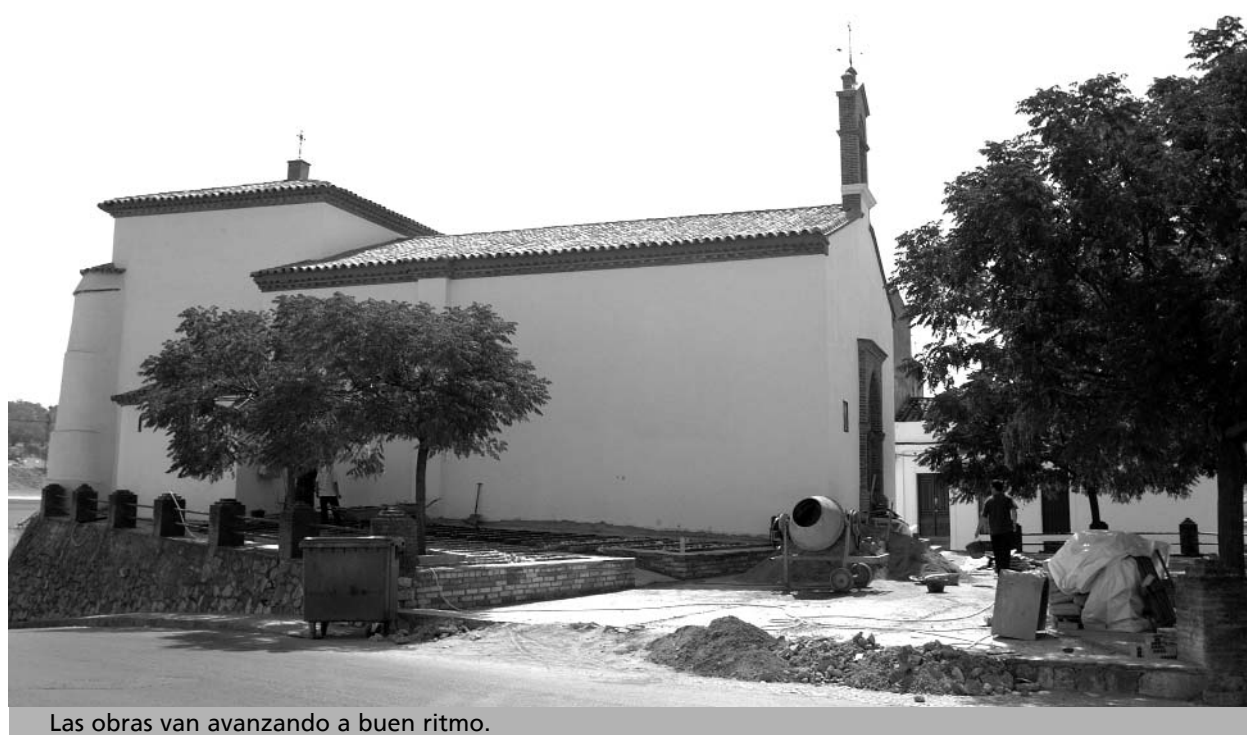
Las obras van avanzando a buen ritmo.
