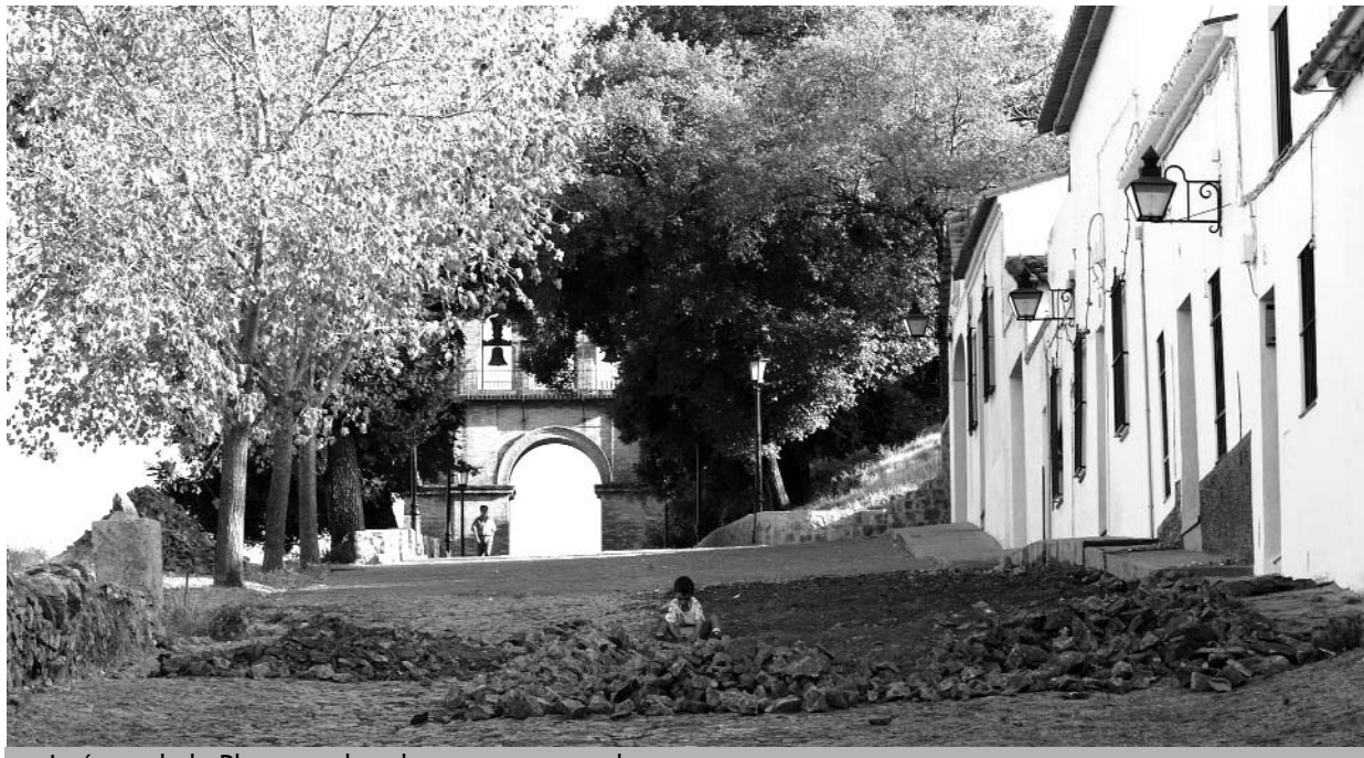
Imágen de la Plaza con las obras ya comenzadas.
