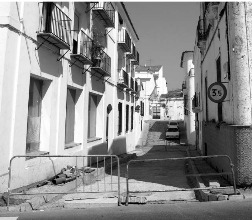
La calle Licenciado Carrión presentaba un estado muy deteriorado.
